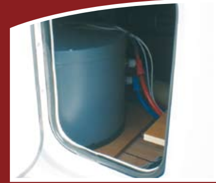
Accès au Boiler par portillon extérieur
