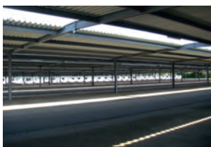
2011 Toits de protection contre la grêle
