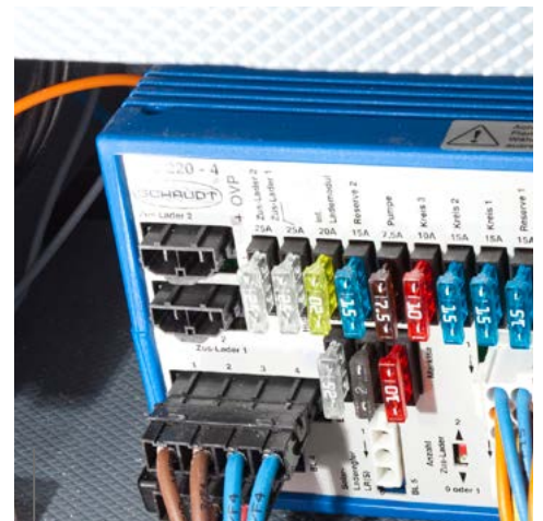
Bloc de sécurité facilement accessible
