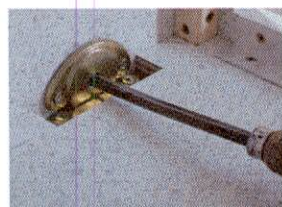
Démontage à l'aide d'un simple tournevis
