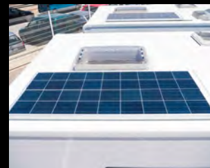
■ Panneau solaire de 140W
