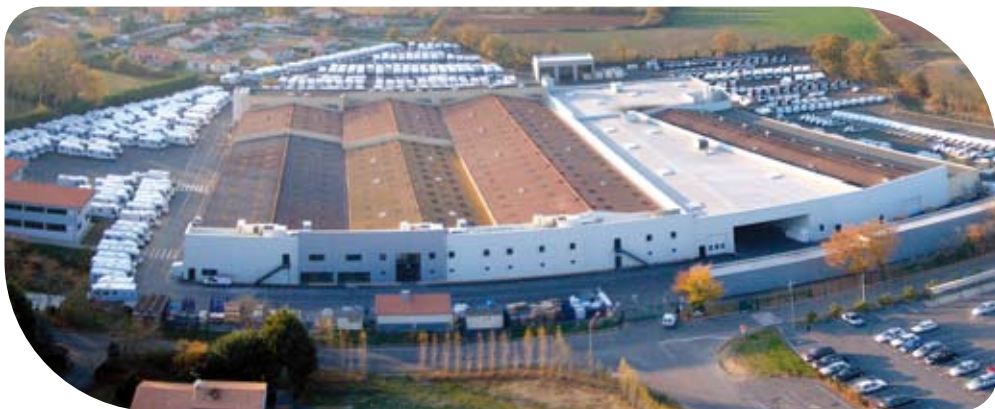
Usine BAVARIA de La Limouzinière, site de fabrication des modèles Arctic et Baltic
